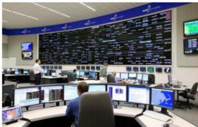
Figure 1.19 : Exemple d'un centre de dispatching d'un réseau électrique [8]
